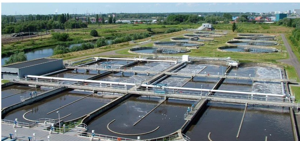
Figure III.1. Station d'épuration des eaux usées ( assainissement collectif ).
